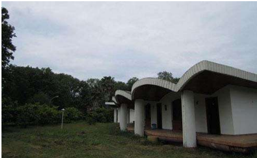
فراخوان ارزیابی کیفی شرکت های پیمانکار جهت انجام مناقصه عمومی مرمت و بازسازی
